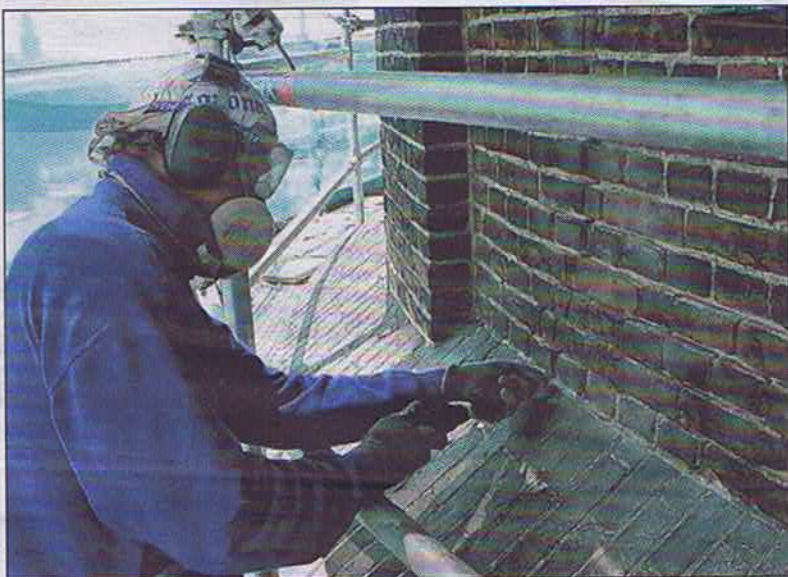
De restauratie van het voegwerk is een precisieklusje. Minutieus wordt elke voeg uitgekraasd en weer gevuld.
